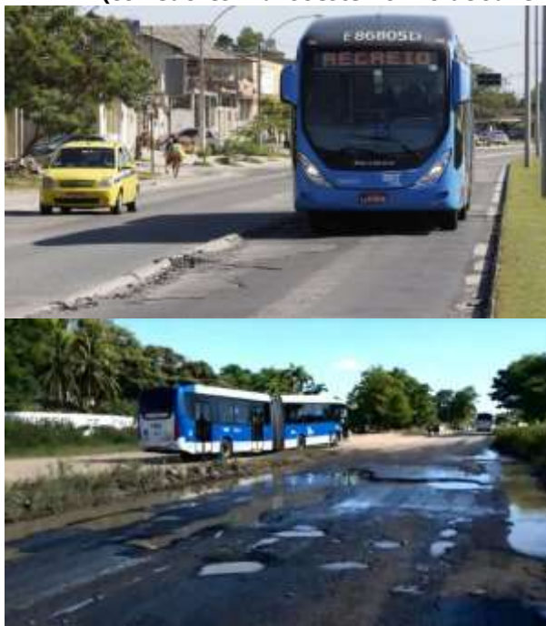
Figuras 1 e 2: Pavimentos de faixas exclusivas danificados (corredores Transoeste no Rio de Janeiro à esquerda e PE-015 na RMR à direita)
