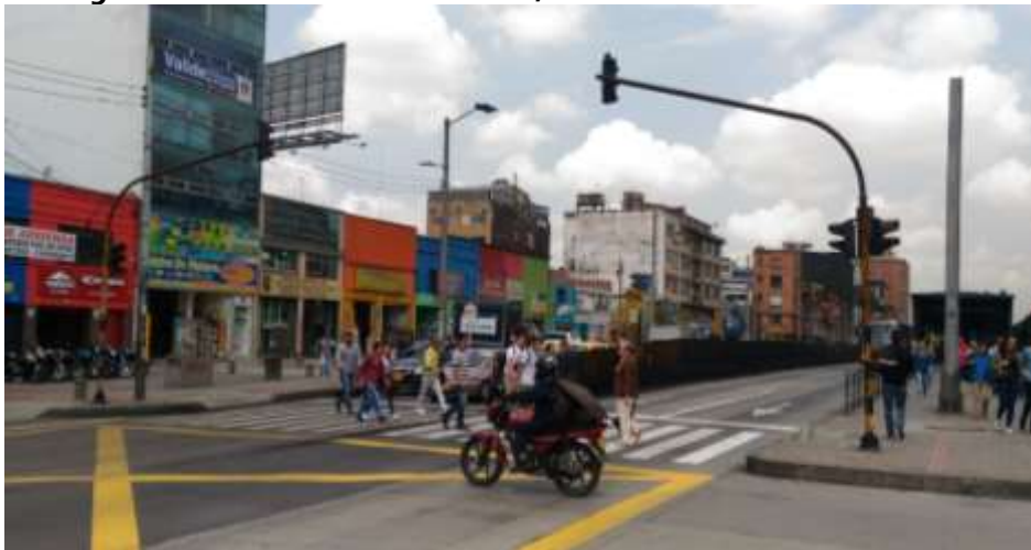
Figura 1. Corredor troncal Caracas, estación Calle 63. Transmilenio
