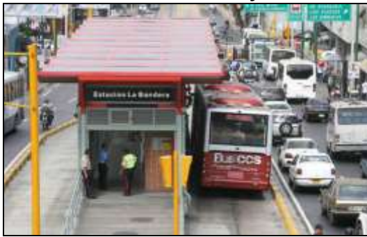
Figura 3: Imagen de estación, canal exclusivo y bus articulado del BusCaracas
